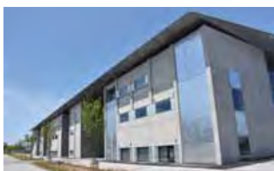
生産技術研究所附属千葉実験所研究実験棟I
