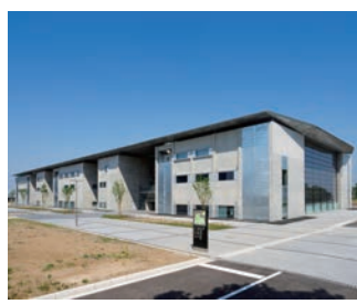
生産技術研究所研究実験棟I
