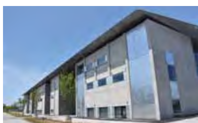
生産技術研究所附属千葉実験所研究実験棟I
